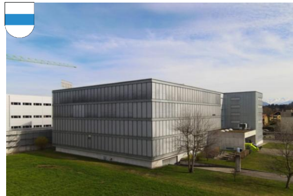
Produktions- und Logistikgebäude in Rotkreuz mit 10'790m 2 Nutzfläche
