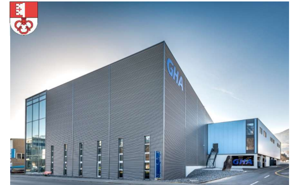
Produktions- und Logistikgebäude in Alpnach mit 7'117m 2 Nutzfläche
