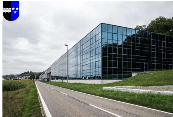
Produktions- und Logistikgebäude in Dottikon mit 5'670m 2 Nutzfläche
