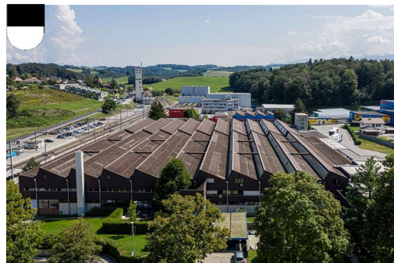
Industrie- und Logistikgebäude in Schmiten mit 18'610m 2 Nutzfläche
