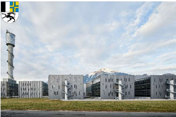
Produktions- und Logistikgebäude in Landquart mit 12'935m 2 Nutzfläche
