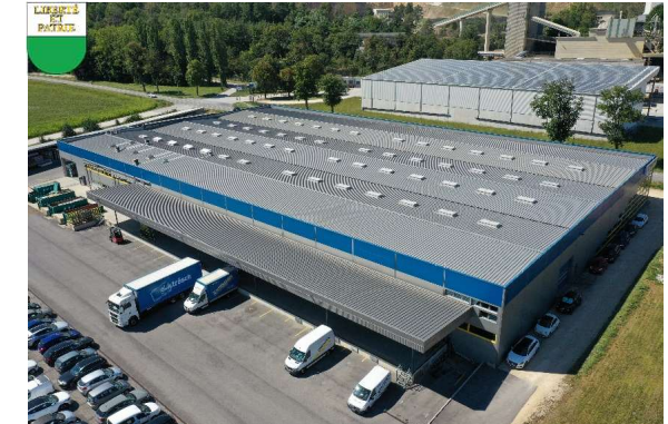
Produktions- und Logistikgebäude in Eclépens mit 7'210m 2 Nutzfläche
