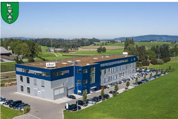
Produktions- und Logistikgebäude in Bronschhofen mit 9'100m 2 Nutzfläche
