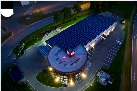
Produktions- und Logistikgebäude in Estavayer-le-Lac mit 2'390m 2 Nutzfläche
